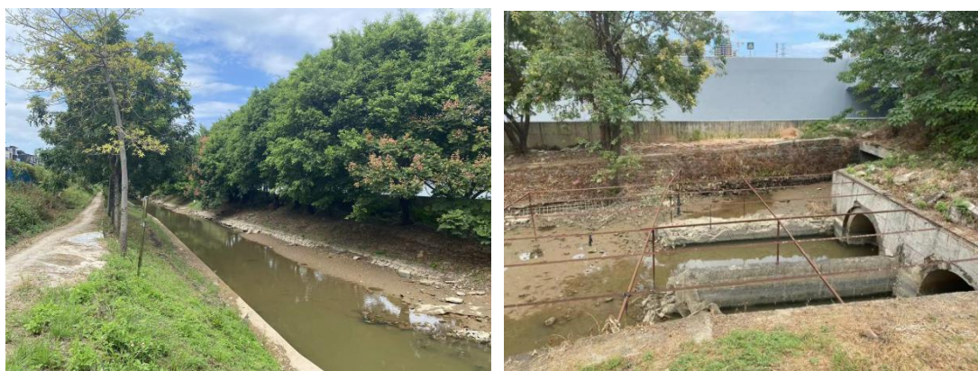
图 3-9 北围排渠现状
