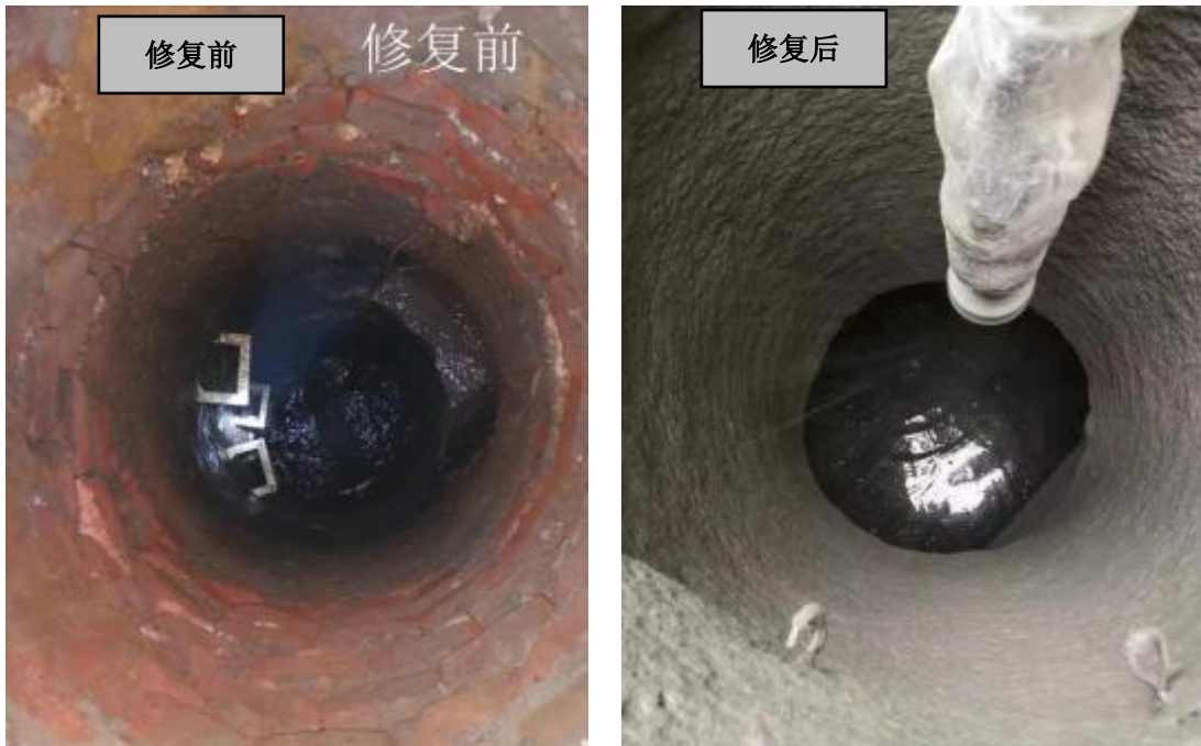
图 5-54 井盾技术（离心喷涂法）前后对比
