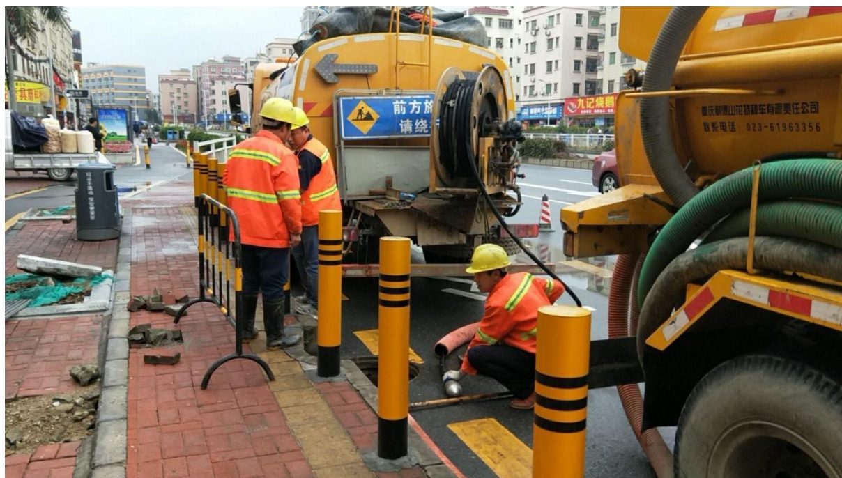
图 5-55 联合吸污车在射水正在作业中的吸泥车
