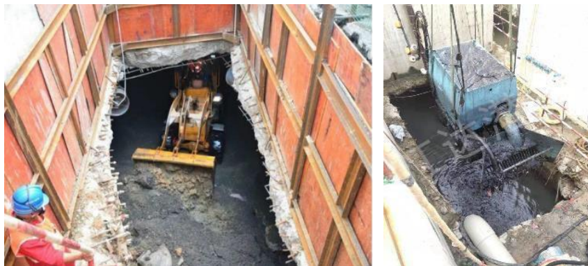
图 5-16 暗涵机械清淤开孔
