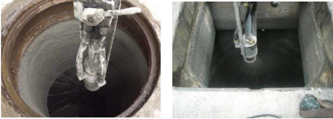
图 5-53 井盾技术（离心喷涂法）修复检查井
