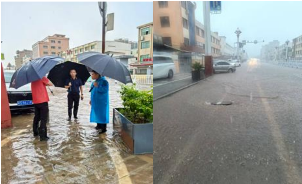
图5.2-49 站前路现场积水情况
