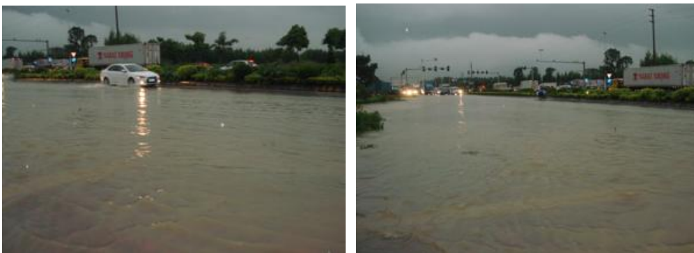
图5.2-56 超横路现场积水情况图
