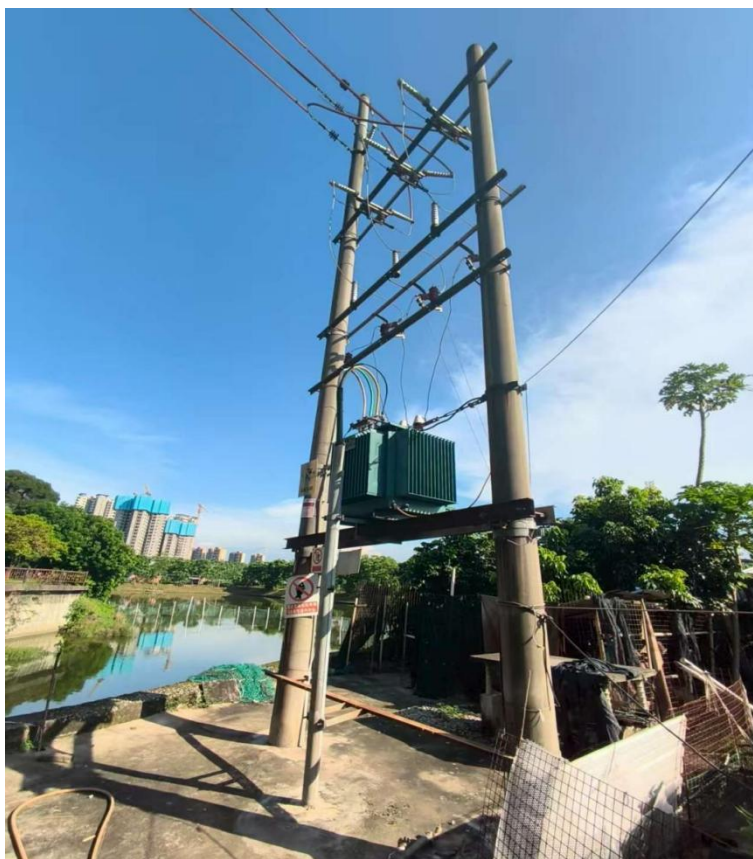
图5.2-100 北围排站户外变压器
