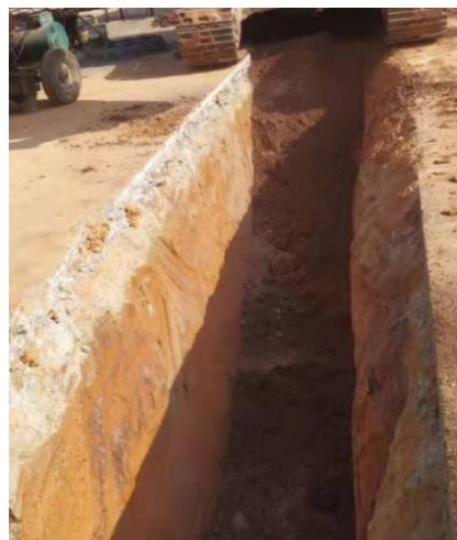
图5.2-106 直接开挖管槽
