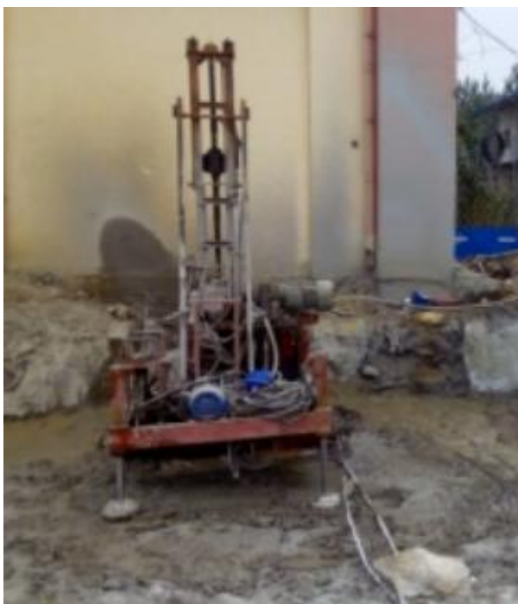
图5.2-111 房屋保护桩施工
