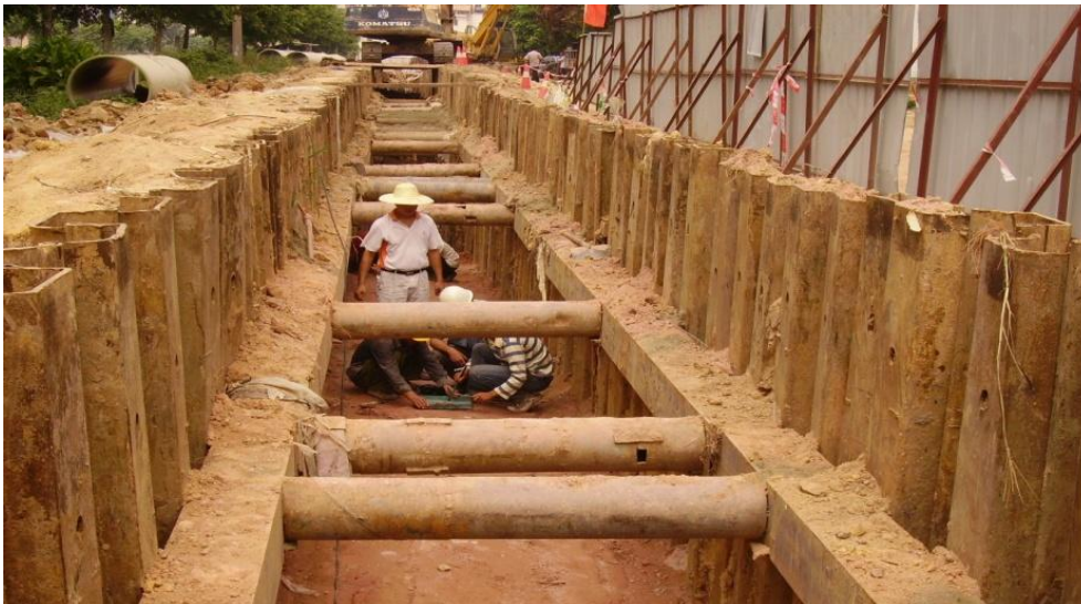
图5.2-109 拉森钢板桩支护开挖管槽
