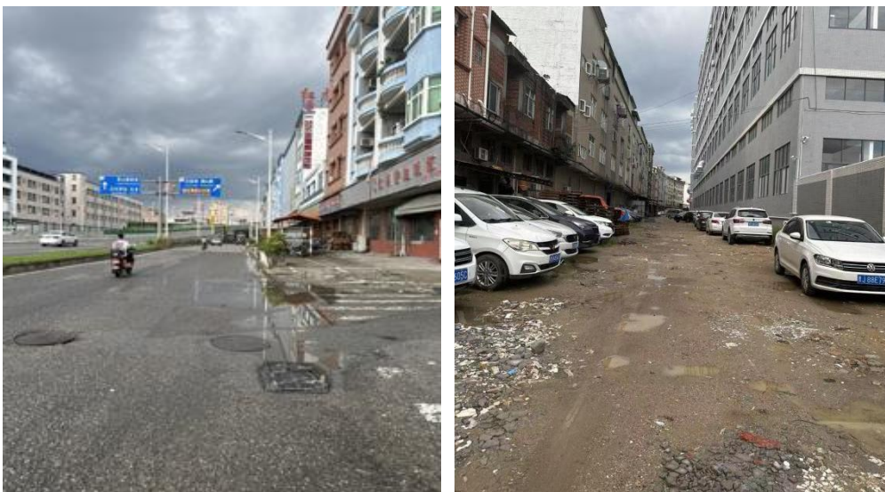
图5.2-43 石大公路现场积水情况
