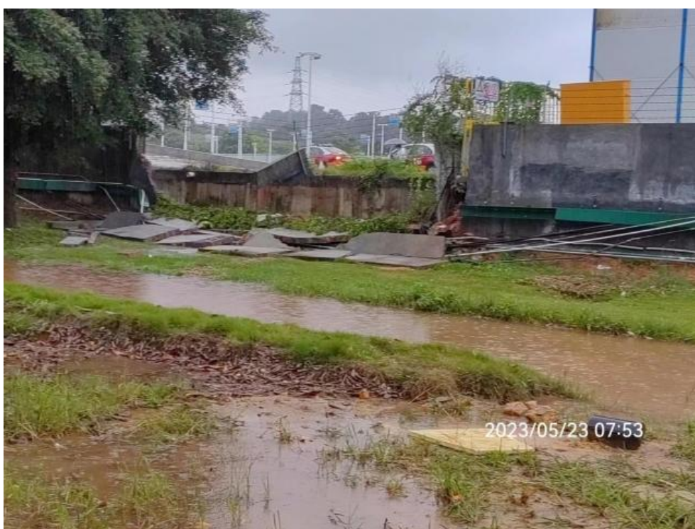
图5.2-18 美极厂房现场积水情况图
